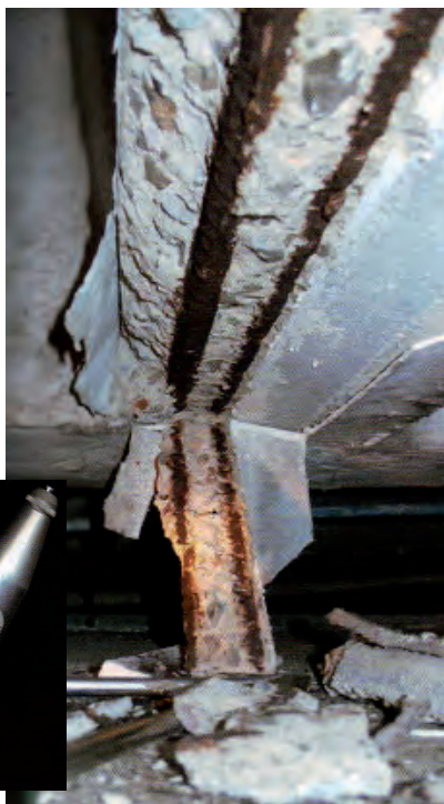
Efecto de la acción de la humedad de condensación continuada en un nervio de forjado reticular industrial. La imagen de la derecha muestra un esclerómetro portátil empleado para medir la resistencia superficial del hormigón
